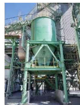
ภาพที่ 2.2-31 ไซโลหรือ Collecting Pit เก็บเถ้าหนักแบบปิด
