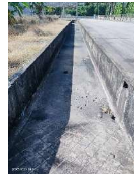
ภาพที่ 2.2-20 ร่องน้ำขนาดกว้าง 2 เมตร ลึก 1.5-2.2 เมตร ล้อมรอบกองถ่านหิน
