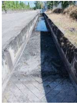
ภาพที่ 2.2-20 ร่องน้ำขนาดกว้าง 2 เมตร ลึก 1.5-2.2 เมตร ล้อมรอบกองถ่านหิน
