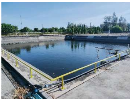
ภาพที่ 2.2-17 บ่อพักน้ำทิ้งรวม (Retention Pond)
