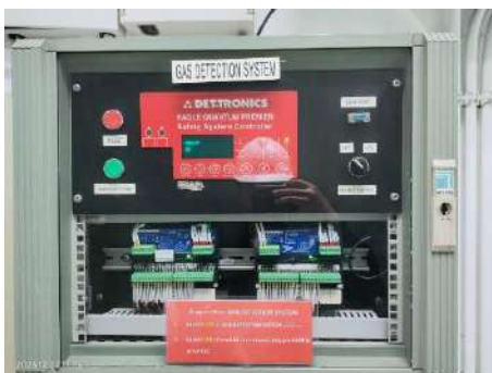
ภาพที่ 2.2-43 อุปกรณ์ตรวจสอบก๊าซไฮโดรคาร์บอน
