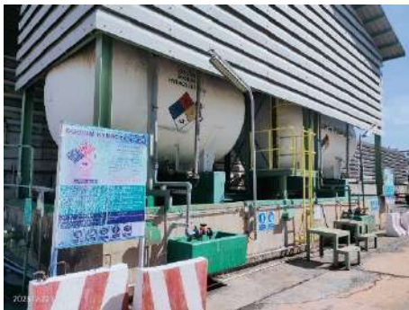
ภาพที่ 2.2-16 Dike สำหรับถังเก็บสารเคมีและถังสำรองเชื้อเพลิง
