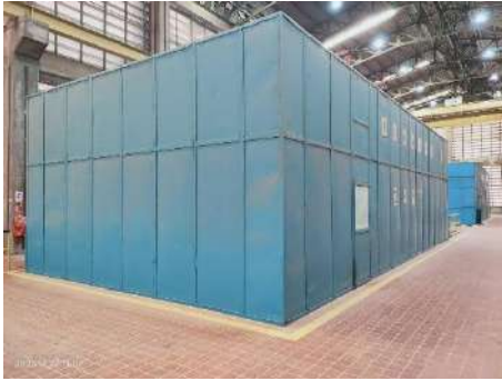
ภาพที่ 2.2-41 อุปกรณ์ลดเสียง Silencer และปิดครอบเครื่องจักรที่มีเสียงดัง
