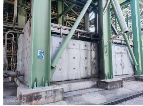
ภาพที่ 2.2-41 อุปกรณ์ลดเสียง Silencer และปิดครอบเครื่องจักรที่มีเสียงดัง
