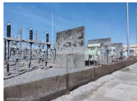
ภาพที่ 2.2-44 Fire Wall บริเวณ Transformer และอุปกรณ์ป้องกันฟ้าผ่า
