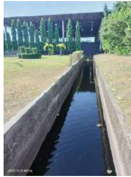
ภาพที่ 2.2-15 การตรวจสอบรางระบายน้ำฝนในพื้นที่โครงการ
